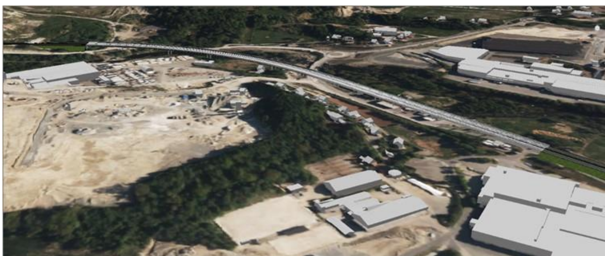
Figur 1.20: Viadukten ved Foss-Eikeland er en lang bro.
